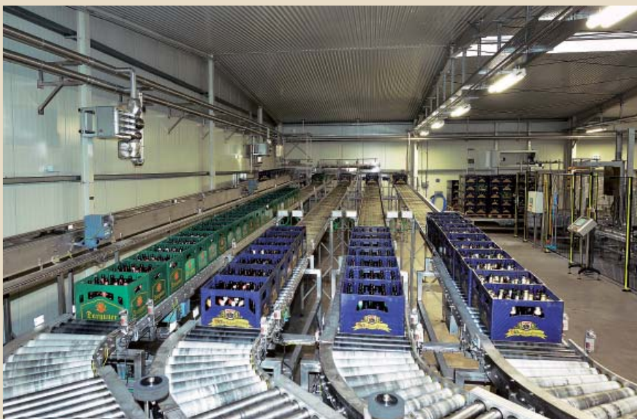
Abb. 1 Edelstahl-Transportanlage mit vier Bahnen
